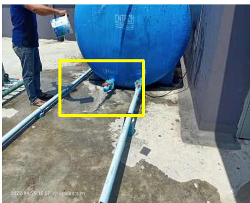
รูปที่ 18 เจ้าหน้าที่ทำความสะอาดถังเก็บน้ำสำรองชั้นดาดฟ้า
